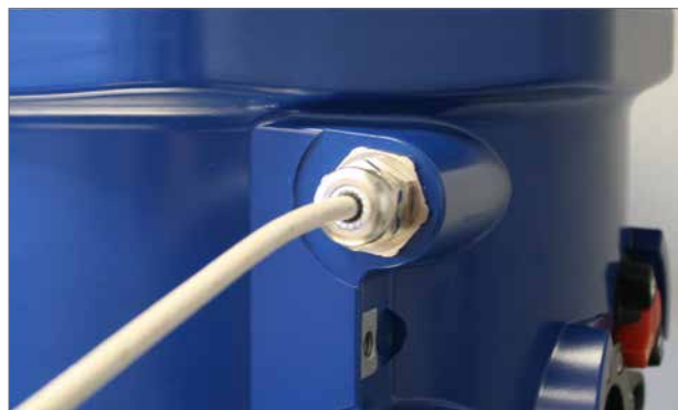
Рис. 6.8 Установка кабельных вводов
