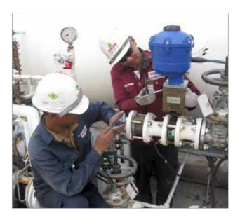
Электрический регулирующий приводения (CVA) с с резервным блоком питания для перехода в безопасное положение при сбое питания или сигнала управления закрывает клапан за 15 секунд, что превосходит требования к применению и решает проблему технического обслуживания для заказчика.
